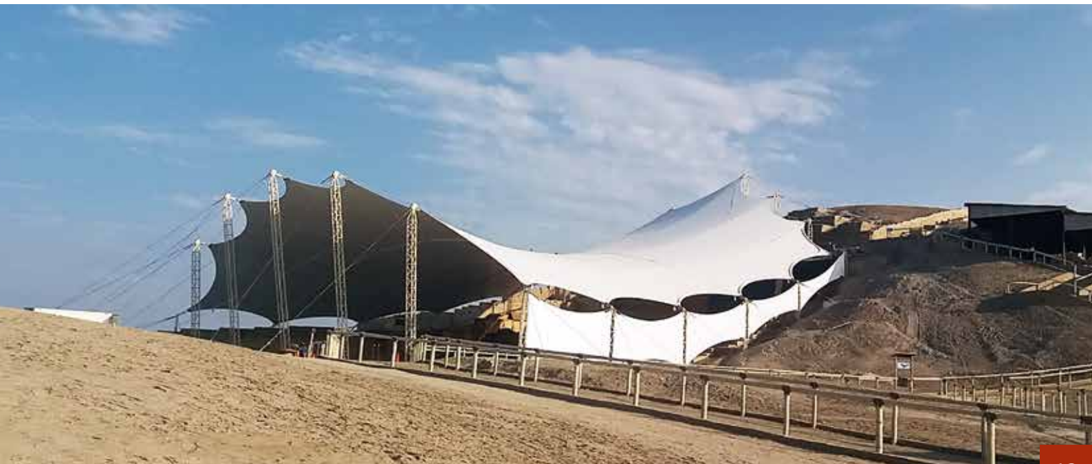
Complejo Arqueológico el Brujo - Huaca Dama de Cao (Cambio de cobertura), 2 271m 2 - Trujillo, Perú.
