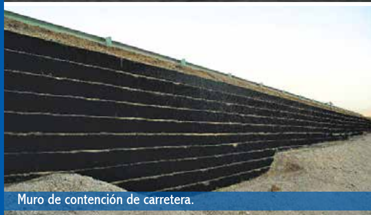
Sistema de protección de geomembrana.
