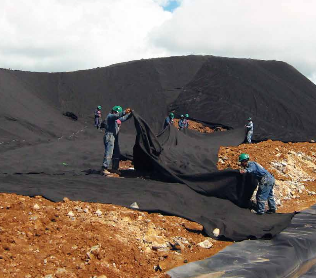
Geotextil como protección de geomembrana.
