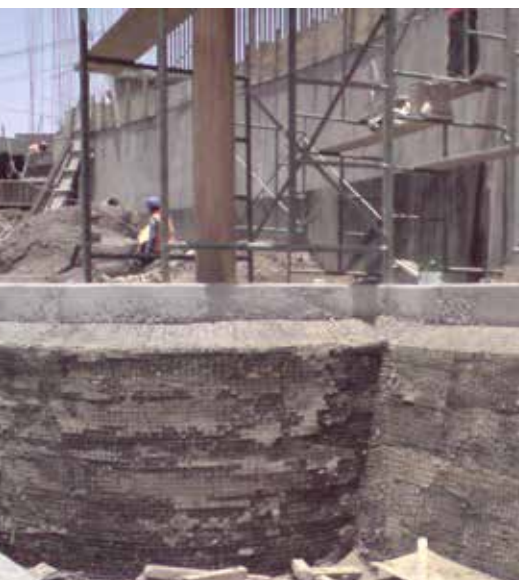
Estabilización de muro con geomallas y revegetación con terrabolsas - Parque temático de dinosaurios en Tacna.
