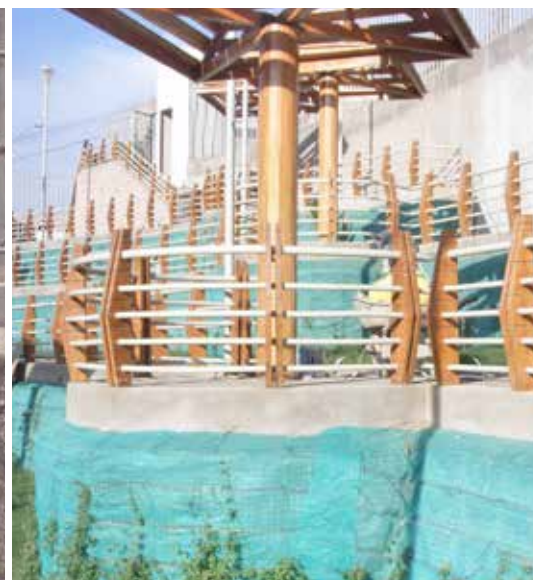
Estabilización de muro con geomallas y revegetación con terrabolsas - Parque temático de dinosaurios en Tacna.
