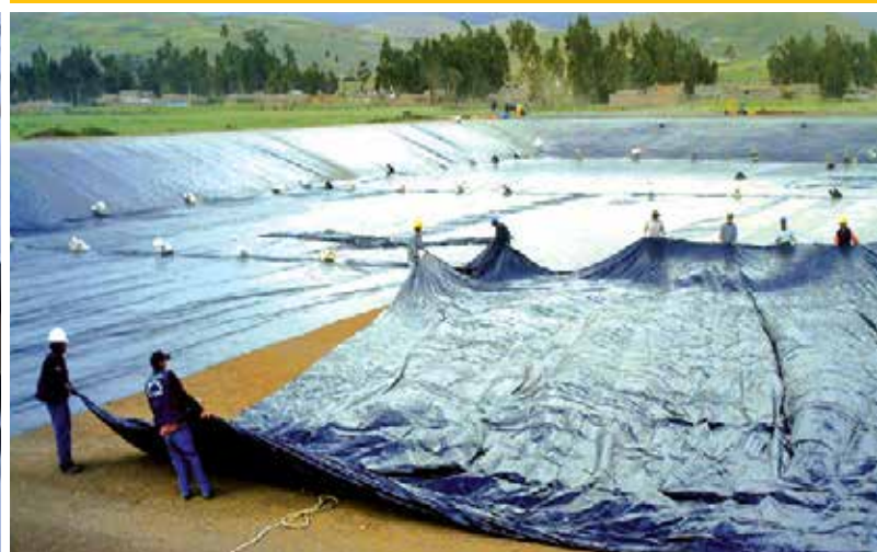
Instalación de paneles en obra.
