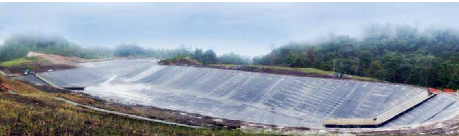
Instalación de geomembrana de HDPE en Costa Rica
