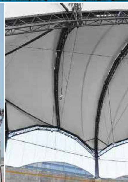
Almacén de minerales IMPALA Luz máx.:80m / Altura: 34m Área Cubierta: 120 000 m 2 , Lima - Perú.
