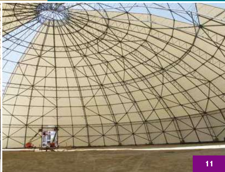
Domo Pacasmayo - Piura / 2014 Altura: 39m / Diámetro de la base: 125m Volumen total: 62 500m 3 Área Cubierta: 12 271 m 2 .
