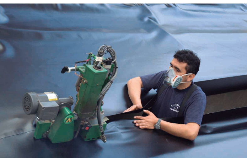
Fabricación de paneles.
