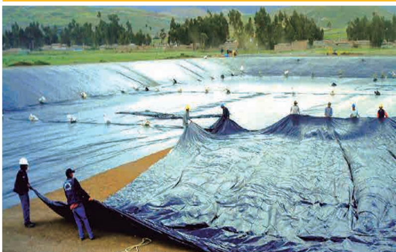
Instalación de paneles en obra.
