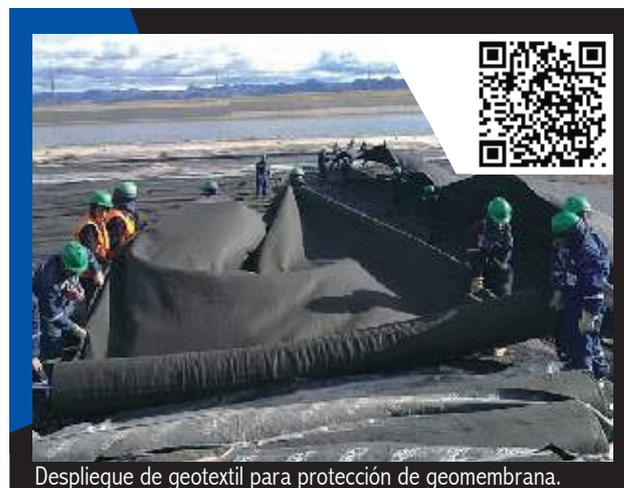
Despliegue de geotextil para protección de geomembrana.
