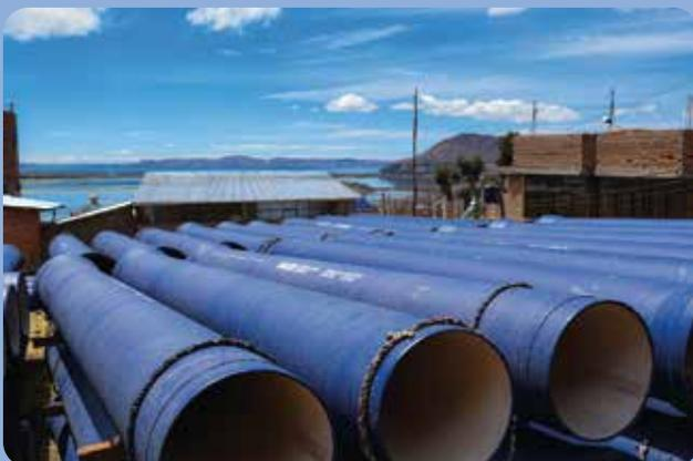
El proyecto contempla la construcción de una estación de bombeo con tanque cisterna de 450 m<sup>3</sup>, una línea de impulsión de 4.4 km, un reservorio de 2500 m<sup>3</sup> y un empalme de reservorio, donde SAINT-GOBAIN PAM ha suministrado 2.8 Km de tubería en DN 600 con revestimiento Zinalium® en la primera etapa del proyecto.
