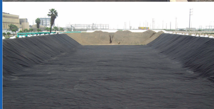
Sistema de protección de geomembrana.
