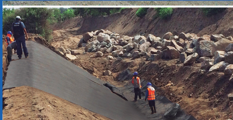
Geotextil de protección para enrocado de dique.
