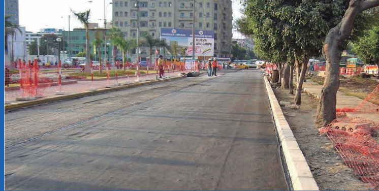
Repavimentación de avenidas.
