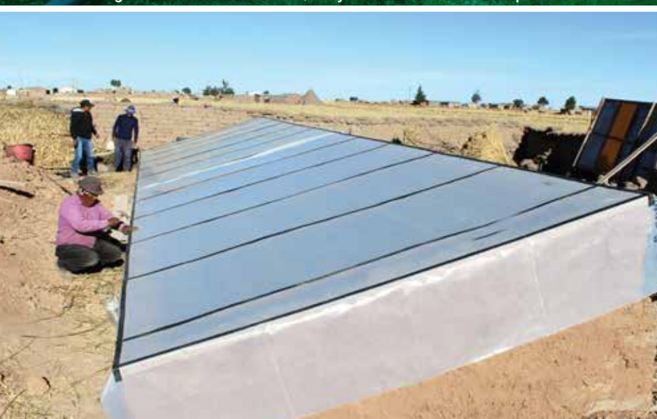
Biodigestor andino de 30m 3 - Proyecto Care, Puno.
